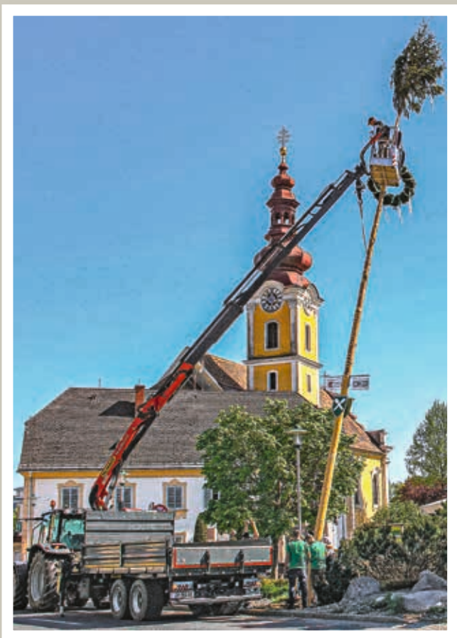
Sicherheit geht vor: Der mächtige Aufbaukran von Walter Neuhold aus Prosdorf hob den Baum in die Senkrechte und setzte ihn vorsichtig in den dafür vorgesehenen Schacht ein.
